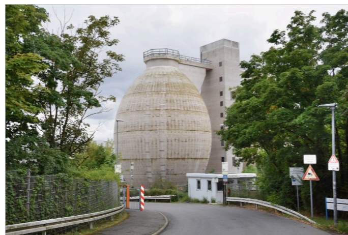
Kläranlage der Stadtentwässerung Hannover.
