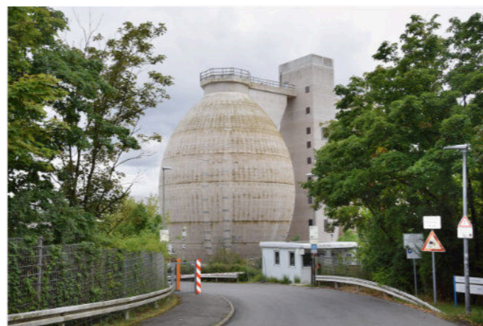
Kläranlage der Stadtentwässerung Hannover.
